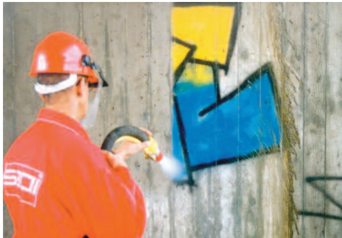
Die „Vario-Niederdruck-Schonstrahl-Reinigungstechnik“ entfernt Graffiti je nach Untergrund mit unterschiedlichen Feinstrahlmitteln
