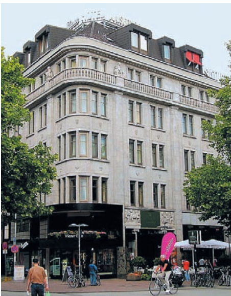
Die Fassade des Hotels Kaiserhof in Hannover nach der Reinigung
