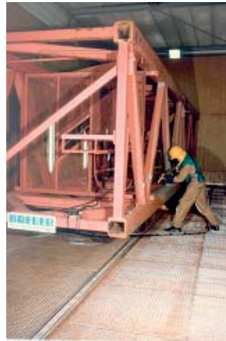
Stahlkonstruktionen Steel construction
